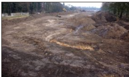
Výstavba nového koryta.
