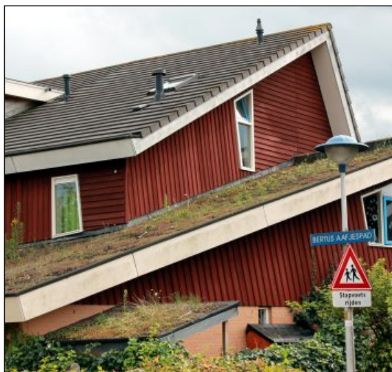
Zelené střechy i infiltrační pásy poskytují prostor pro zasakování dešťové vody.
