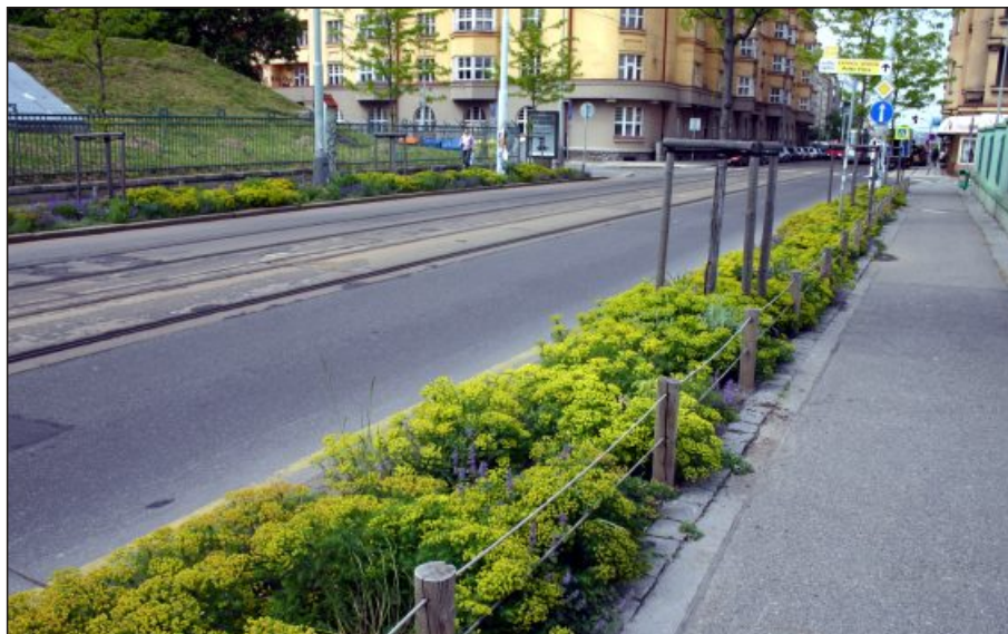
Štěrkový záhon v Jičínské ulici poskytl plochu pro zasakování dešťové vody.
