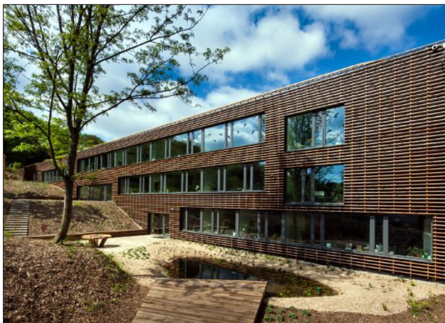
Kořenová čistírna efektivně čistí použitou vodu z umyvadel a zároveň v letních měsících výparem ochlazuje vzduch.
