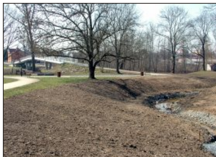
Průleh ochrání zastavěnou část Božkovského ostrova až před tzv. pětiletou povodní.
