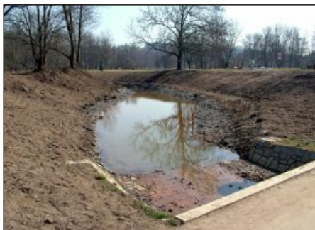
Průleh ochrání zastavěnou část Božkovského ostrova až před tzv. pětiletou povodní.
