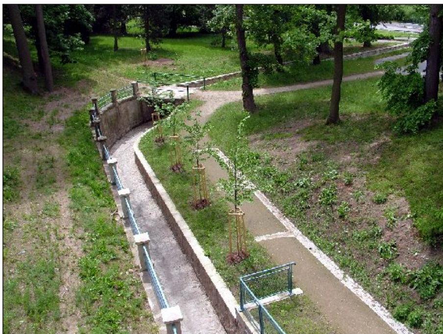
Přes obnovené původní kamenné vodní koryto vede nová pěší lávka.
